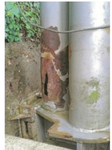
Starke Korrosionsschäden am Steg
