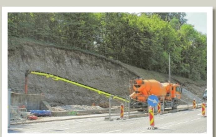
**Baustelle** Im Bereich des Gymnasium Werndlpark sind die Bauarbeiten für einen Geh- und Radweg voll im Gang. Der Hang wurde bereits abgegraben, nun wird eine Stützmauer errichtet. Bis Schulbeginn sollen die Arbeiten im Bereich des Gymnasiums abgeschlossen sein. Der gesamte Geh- und Radweg, der bis zum Fußgängerübergang Märzenkeller führt, soll Ende September fertig sein.
