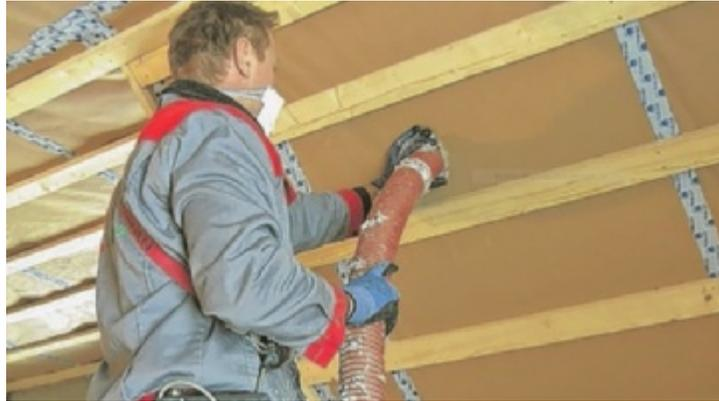
Die Zellulosefaser-Dämmung wird in die Hohlräume eingeblasen. Foto: Austrozell
