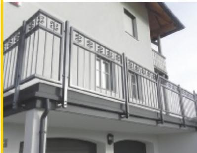
» Geländer in Stahl verzinkt und pulverbeschichtet
