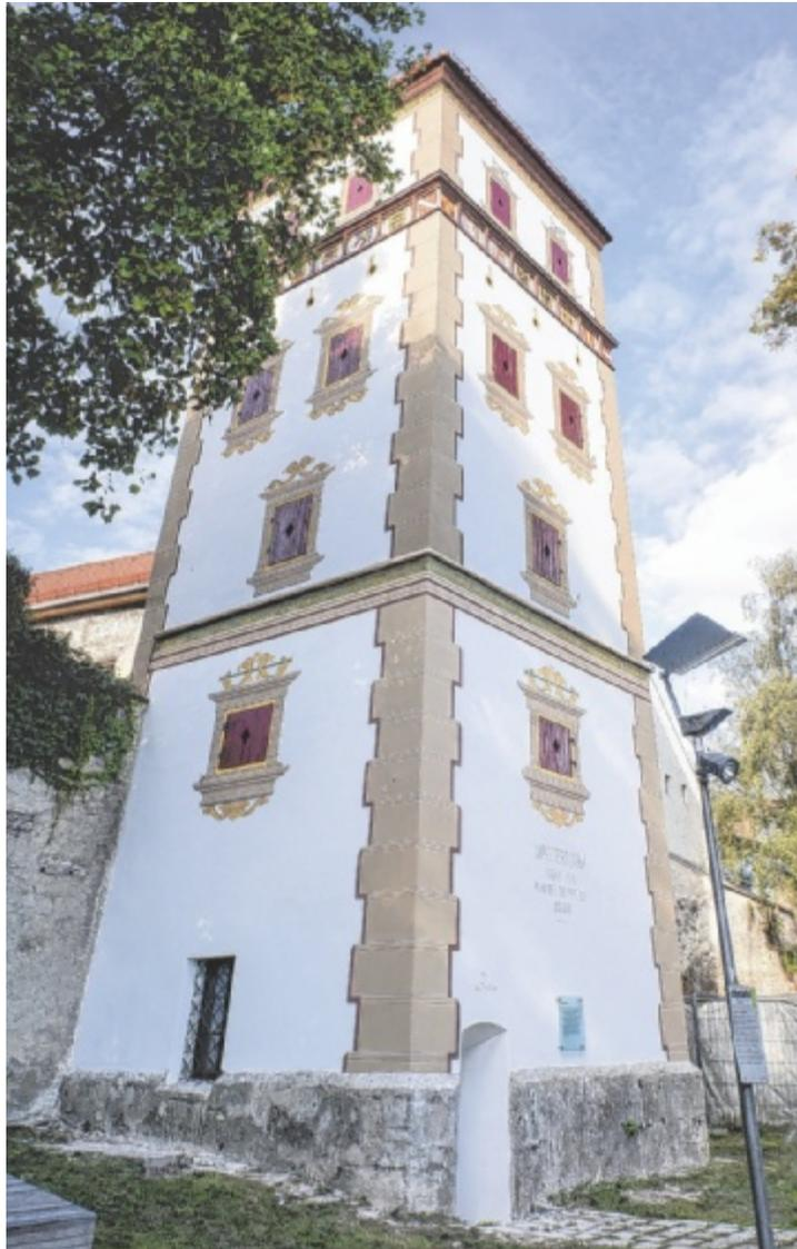
**Ein Blickfang** Die Sanierungsarbeiten im Innen- und Außenbereich des Wasserturms am Zwinger sind abgeschlossen. Das Wappenfries ist wieder in der Originalfassung zu sehen. Das Dach ist neu eingedeckt sowie die Holzläden, Fenster und Türe erneuert. Die Firma Oberbauer leistete die mit dem Restaurator akkordierten Fassaden-Malerarbeiten.
