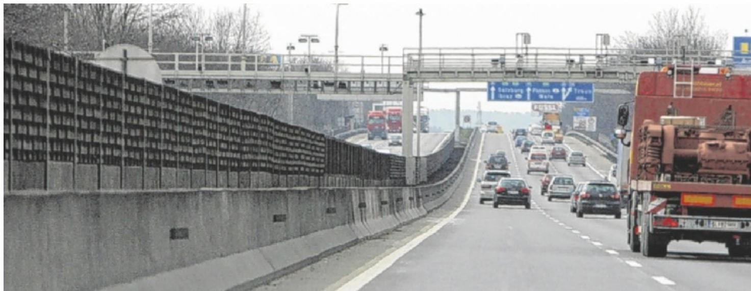
Die Lärmschutzwände zwischen dem Knoten Linz und der Ikea-Brücke werden auf fünfeinhalb Meter erhöht, auch jene am Mittelstreifen.
