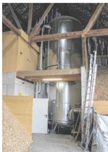
Die von der Anlage erzeugte Wärme wird in einem 37.000 Liter Wasser fassenden Puffer gespeichert.
