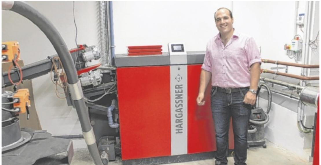
Landwirt Bernhard Eblinger vor der Holzvergaseranlage. Pro Jahr kann Eblinger damit 160.000 Kilowattstunden Strom und 480 Megawatt Wärme erzeugen.
