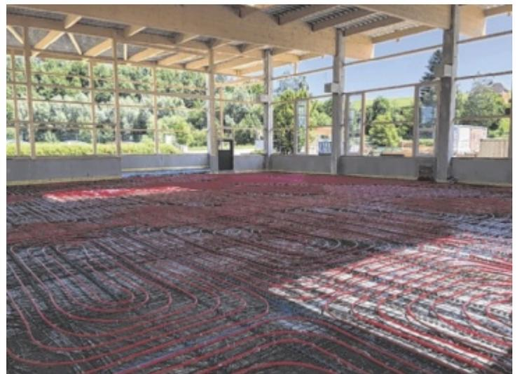
Der Innenbereich der Halle, nachdem die Fußbodenheizung verlegt wurde.
