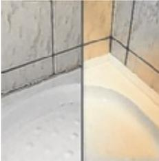
1A Wannenfugensanierung mit **Alu-Dicht-Eckprofil**
