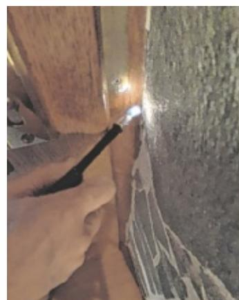
Mit Kerze oder Feuerzeug lässt sich testen, ob die Fugen zwischen Wand und Fenster dicht sind.
