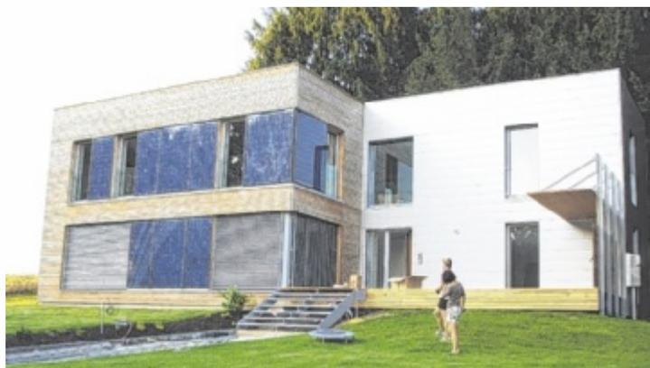
Photovoltaik-Module lassen sich auch in die Fassade integrieren. Foto: Ertex Solar
