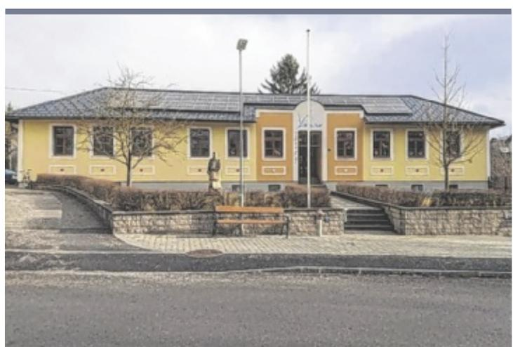
**Energie der Sonne** Die Firma Elektrotechnik Zeiss GmbH montierte auf der Volksschule Kirnberg eine Photovoltaikanlage. Es wurden 68 Modul-Stücke mit je 340 Wp auf der Südost- und der Südwestseite angebracht. Die PV-Anlage ergibt eine Gesamtleistung von 23,12 kWp. Foto: Gemeinde
