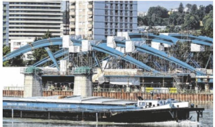
Die Teile werden von den Montageplätzen am Donauufer mit Ponton-Spezialschiffen zu ihren Endstandorten auf den Brückenpfeilern gebracht. Foto: Weibold
