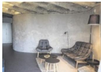
Die Mesh Mould Technologie erlaubt eine geschwungene Wand ohne Spezialschalung – acht Zentimeter dünn und dennoch tragfähig. Fotos: Stadler
