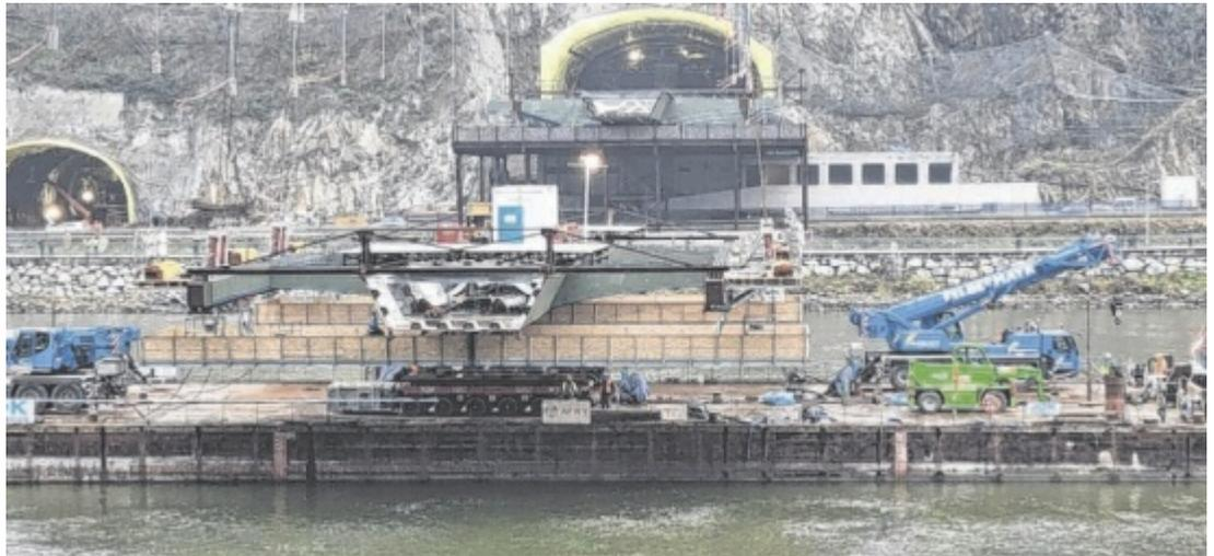
Die Brückenelemente werden in den nächsten Wochen hydraulisch angehoben und montiert.
